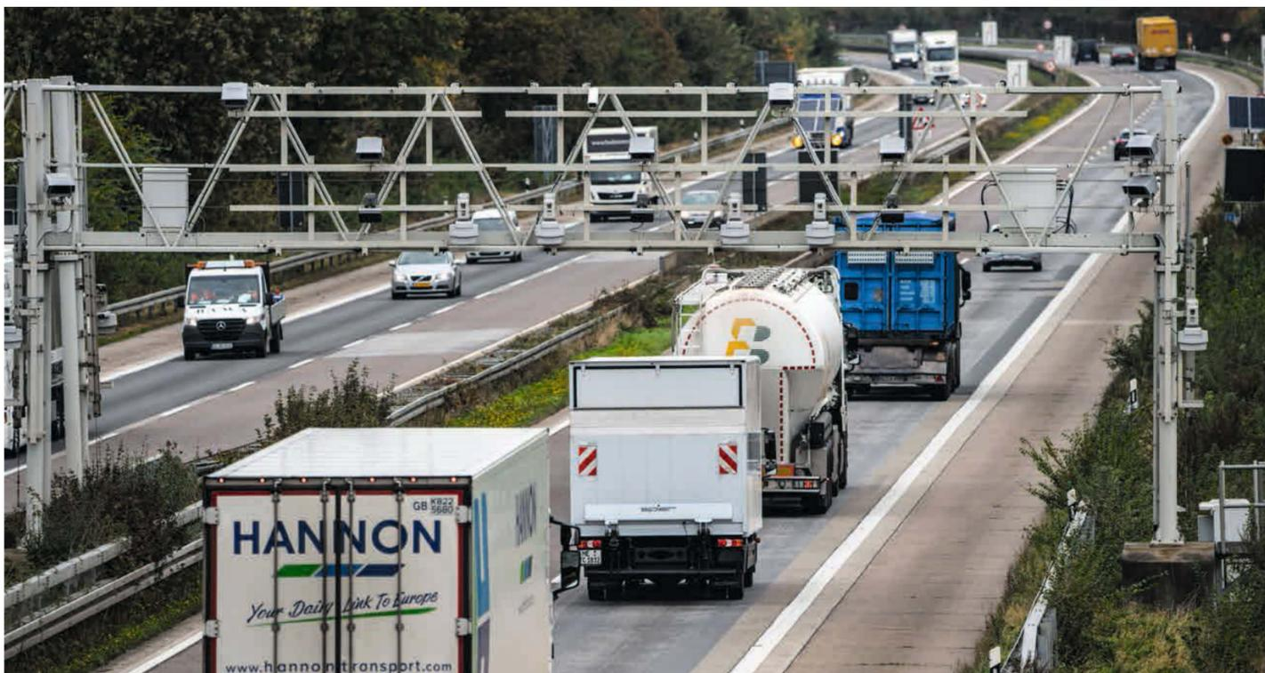
Eine Kontrollbrücke auf der Autobahn, mit deren Hilfe überprüft wird, ob für die mautpflichtigen Fahrzeuge auch tatsächlich die Gebühr entrichtet wird.
