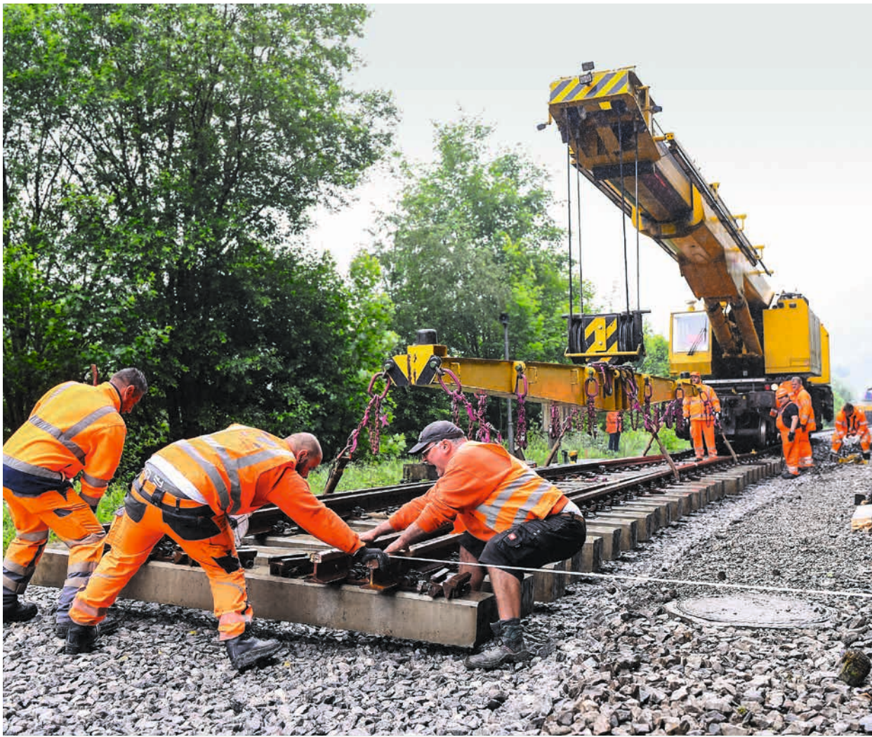
Arbeiten an der Schieneninfrastruktur: Auf der Bahnstrecke Horb- Rottenburg werden beim Bahnhof Eyach Weichen erneuert
