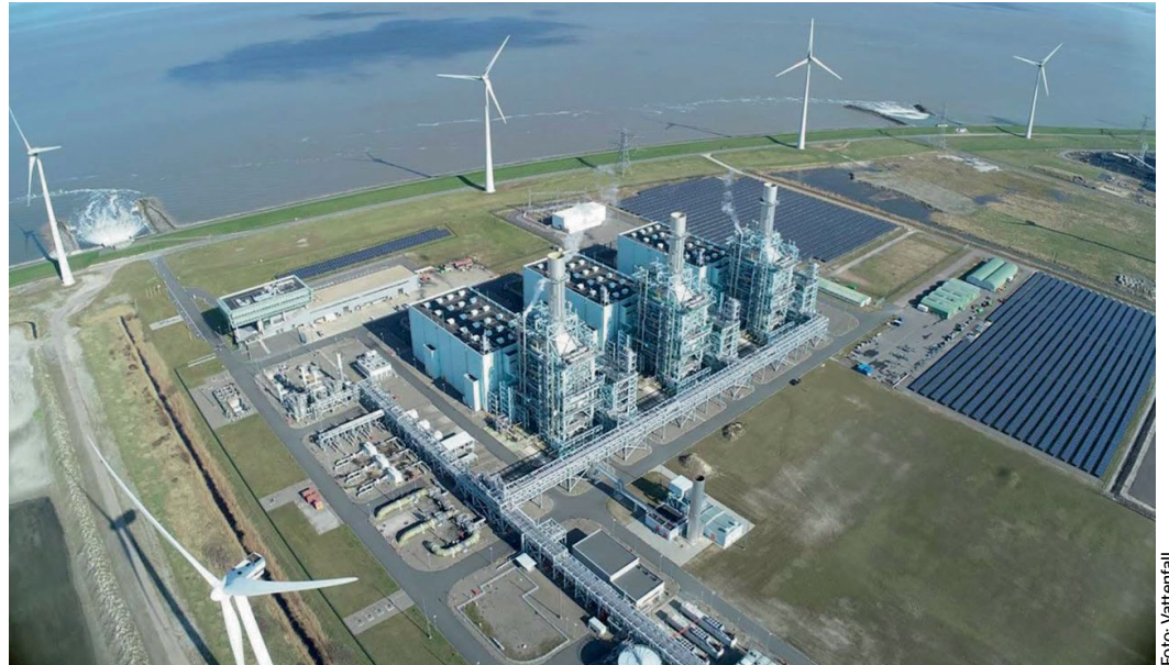
Will RWE von Vattenfall übernehmen: wasserstofffähiges Gaskraftwerk „Magnum“ im niederländischen Eemshaven
